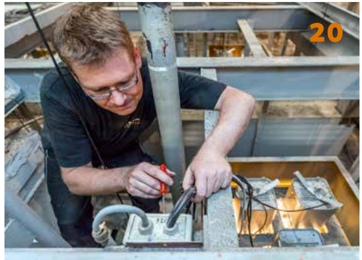
Bühnenlicht: Gewandhauselektriker Michael Laux bereitet den Ausbau der alten Leuchten vor
