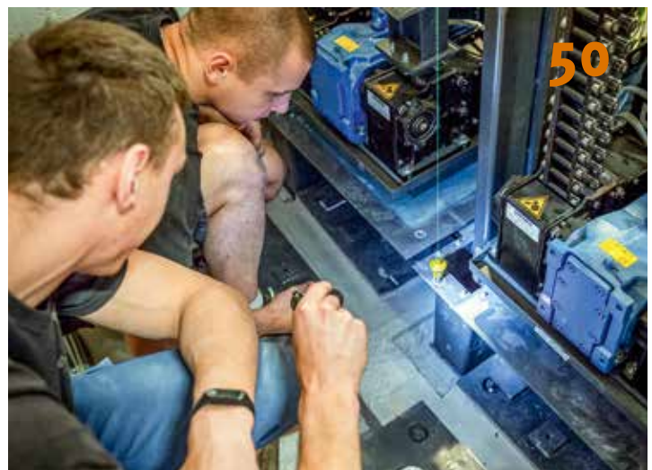
Bühnenumbau: Feinjustierung der neuen Hubpodien durch Mitarbeiter der SBS Bühnentechnik
